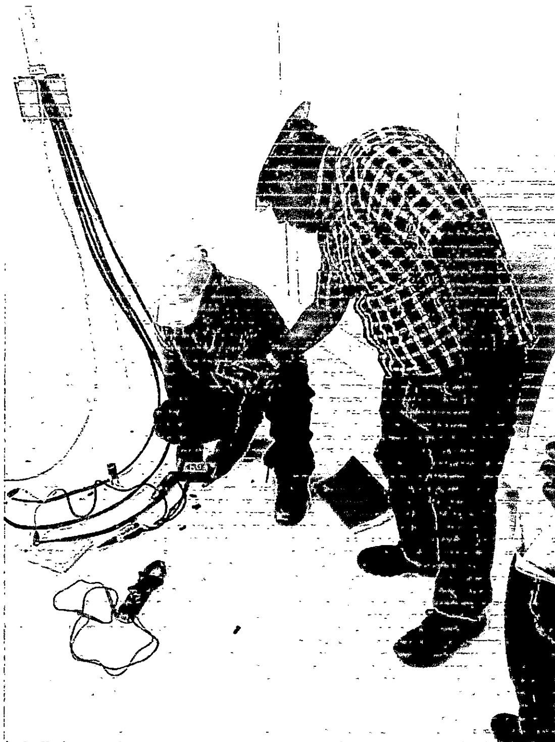
Fotografía N°17: Vista de verificación de fases de circuitos trifásicos.
