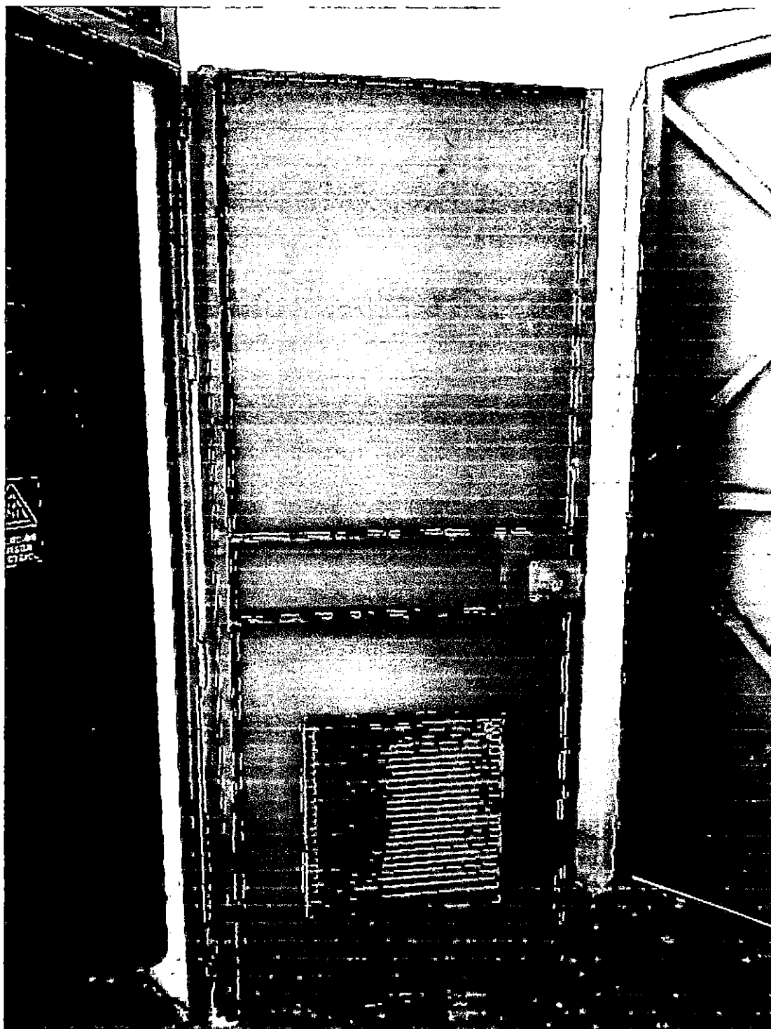
Fotografía N°19: Vista de puerta metálica en subestación eléctrica.
